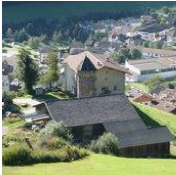
Il maso Steinhaus, presso San Martino.
