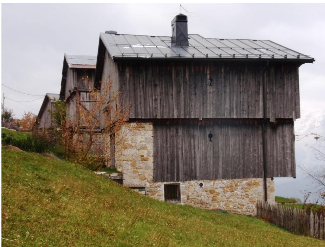
Tre tabiài di Coi, il primo trasformato (all'interno) in abitazione
